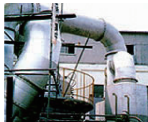
集塵機ダクト(内面)
