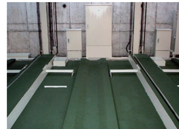
立体駐車場床面 K-888塗布
