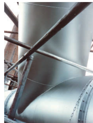
集塵機ダクト(内面)
